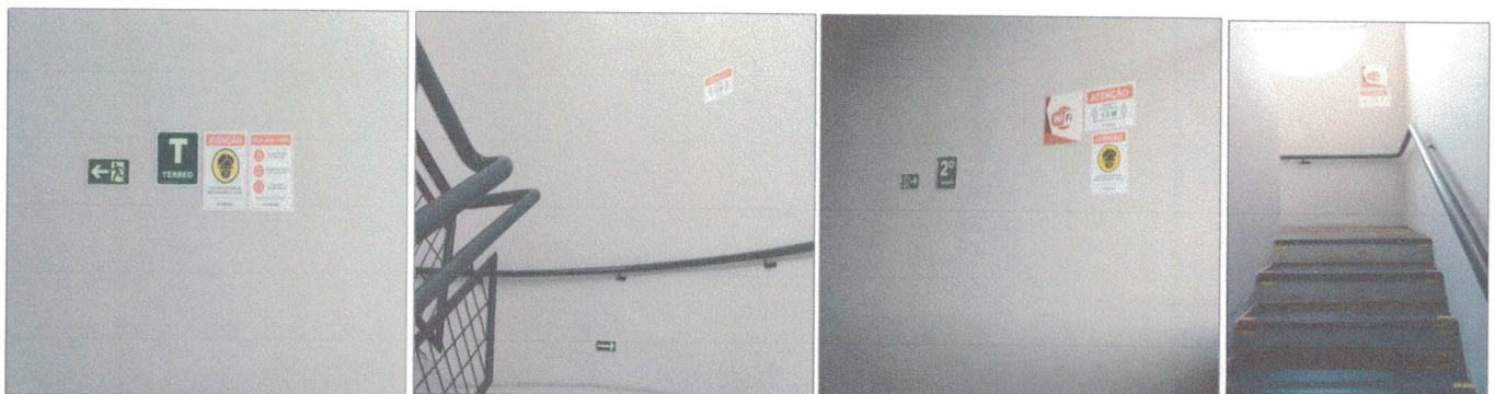
Imagem 4 - Placas de conscientização nas escadas (social e de emergência)
